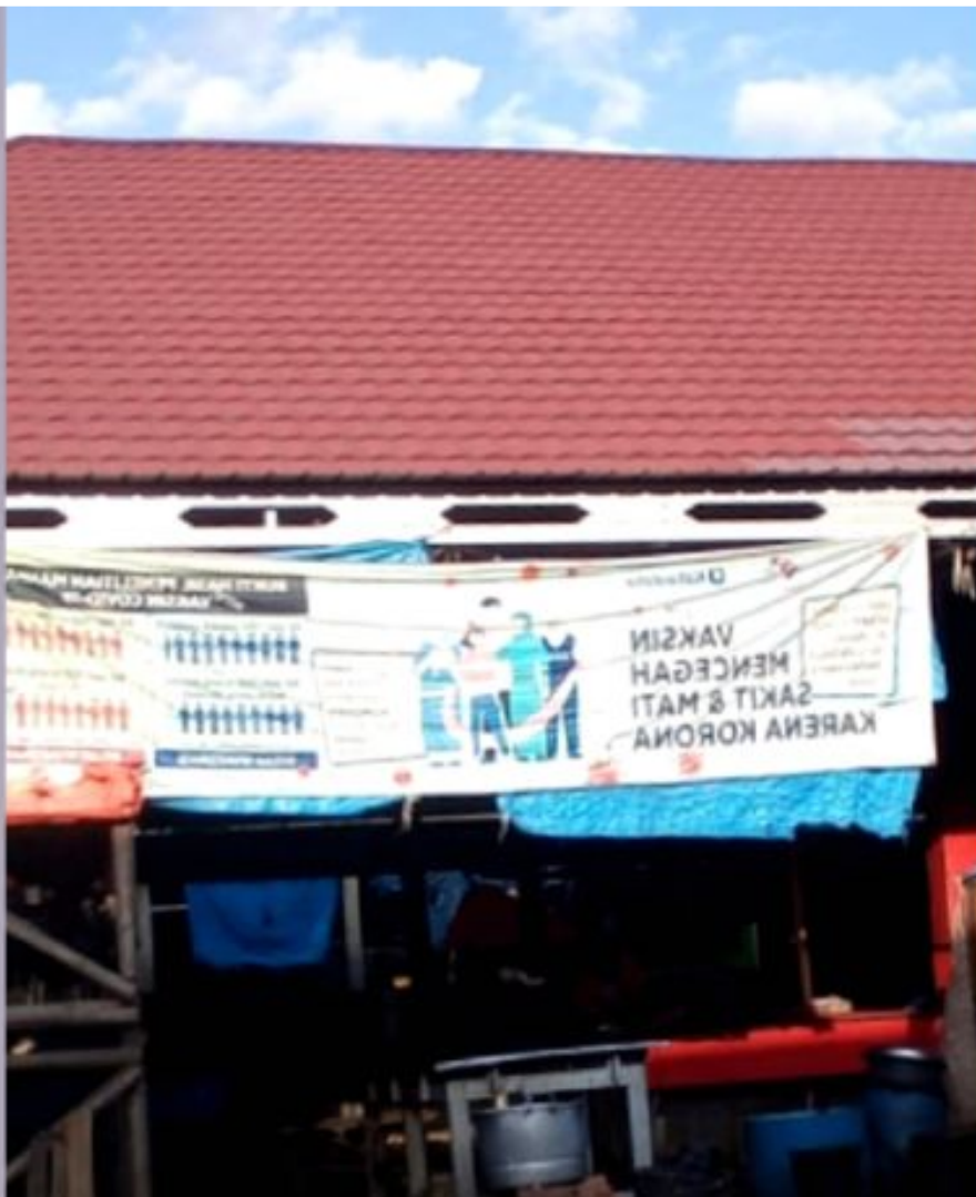
Pembangunan Pasar Sarinah Rimbo Bujang Tebo Senilai 2,2 Miliar.
